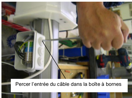
Connecter le luminaire
